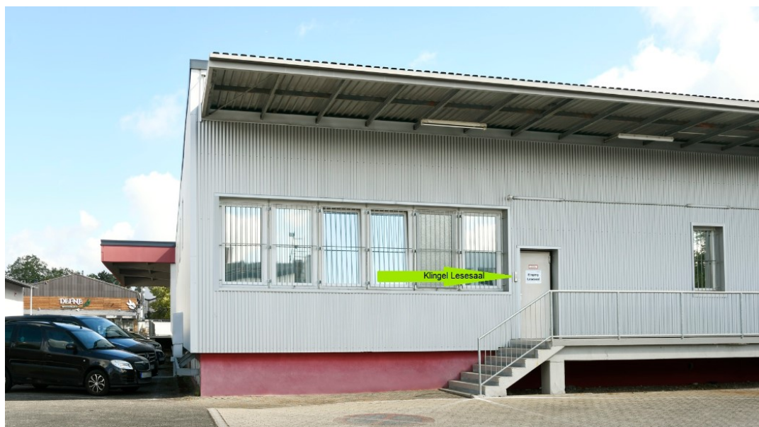
Eingang Lesesaal (auf der Rückseite des Gebäudes)
